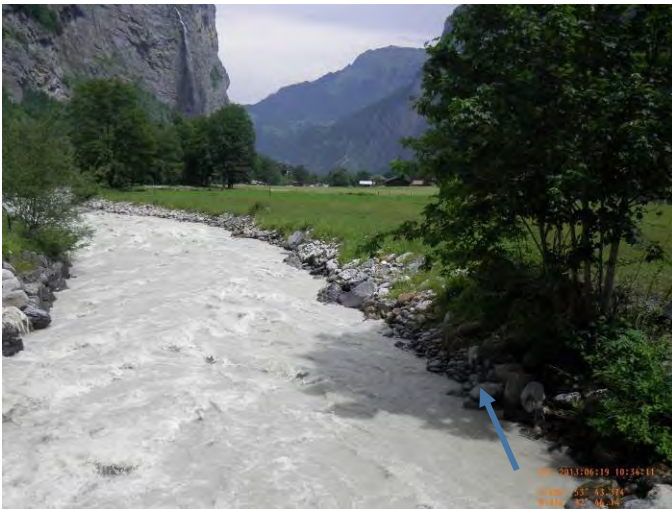
Abbildung 4: Zustand des Abschnittes 1
