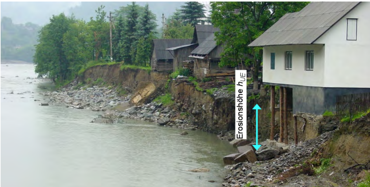
Abbildung 11: Die Erosionshöhe als das Mass, welches die Einwirkung der Ufererosion auf ein Gebäude charakterisiert. Foto Flussbau AG SAH.
