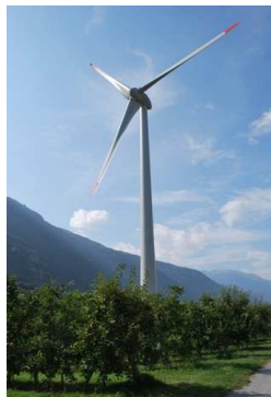
2 MW Windturbine mit Jahresproduktion 5 GWh (RhôneEole in Martigny, seit 2008)
