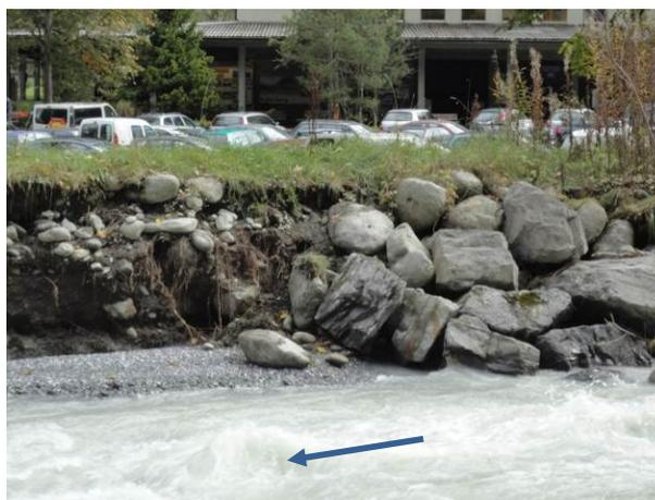
Figure 6: Gros plan de l'érosion et de l'enrochement de la berge
