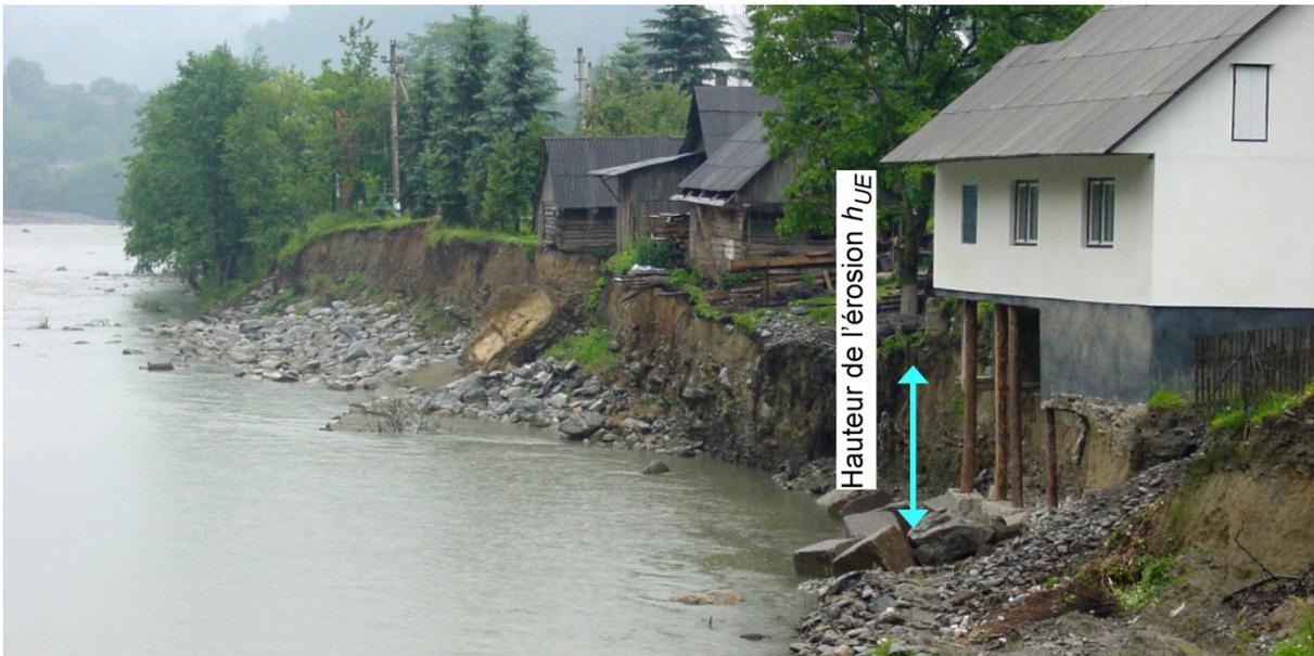
Figure 11: La hauteur de l'érosion sert à mesurer les effets de l'érosion des berges sur un bâtiment. Photo Flussbau AG SAH.
