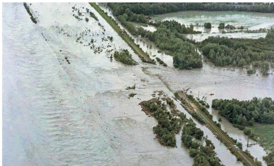
Bild 3. Dammbbruch am unteren Alpenrhein bei Fussach während des Hochwasserereignisses 1987 (Quelle: Archivbild St. Galler Tagblatt).
