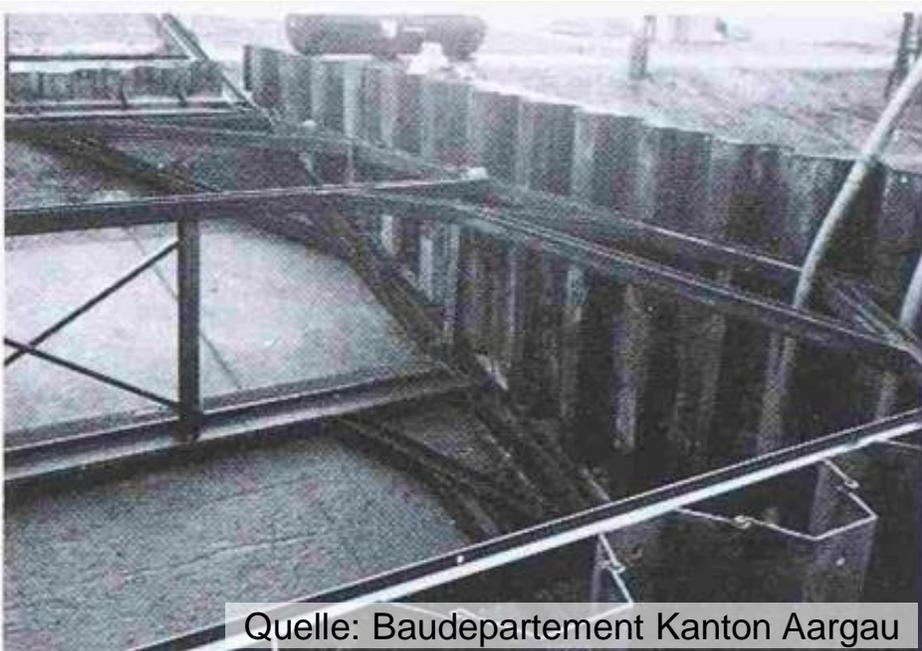
Blick auf die Stahlkonstruktion des Fangedamms während der Erstellung der Aaretalbrücke N3
