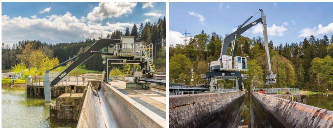
**Abb. 3.27 Beispiel für die Geschwemmselentsorgung mit Stahlrinne am Wasserkraftwerk Altusried an der Iller (Quelle: Künz GmbH).**
