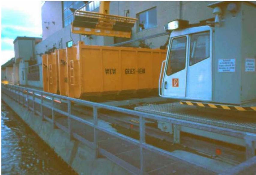
**Abb. 3.25 Beispiel für die Geschwemmselentsorgung mit Direktabwurf am Wasserkraftwerk Griesheim am Main (Quelle: Muhr GmbH).**
