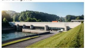
Direkt angeströmtes Blockkraftwerk Ausbauwassermenge Q = 435 m³/s Fallhöhe H = 8 m Jahresproduktion: 150 GWh/a 3 Kaplan-Rohrturbinen 3 Wehrfelder mit Segmentklappen Tosbecken mit Störkörpern Starke Pegelschwankungen im Oberwasser Viel Schwemmholz und Geschiebe
