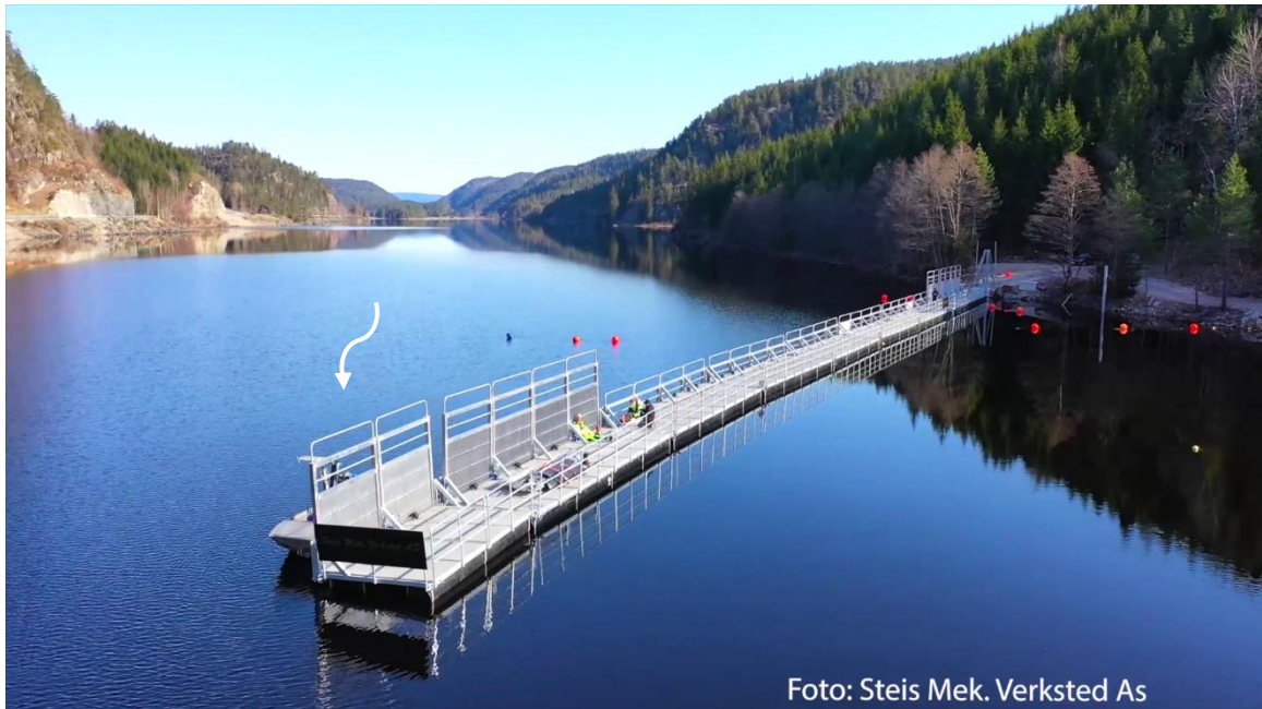
Abb. 3.5 Blick gegen die Fliessrichtung auf den Modified Bar Rack beim Einlauf des Kraftwerks Laudal [34].
