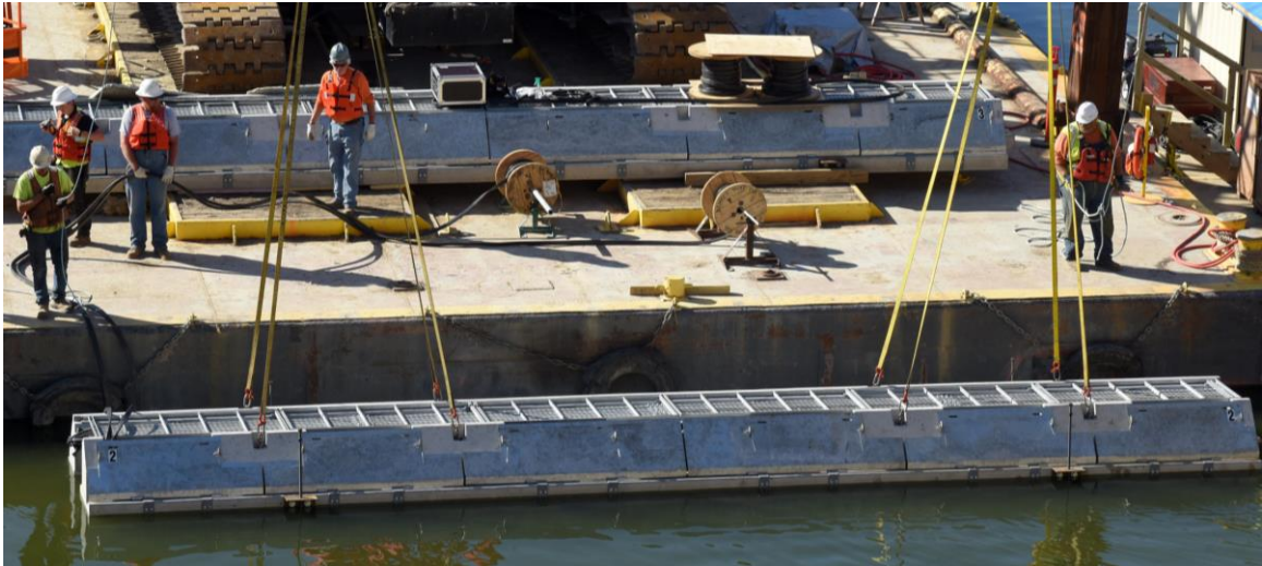
Abb. 3.3 Bild vom Einbau eines BAFF-Elements beim Barkley Dam in den USA (Quelle: [27]).
