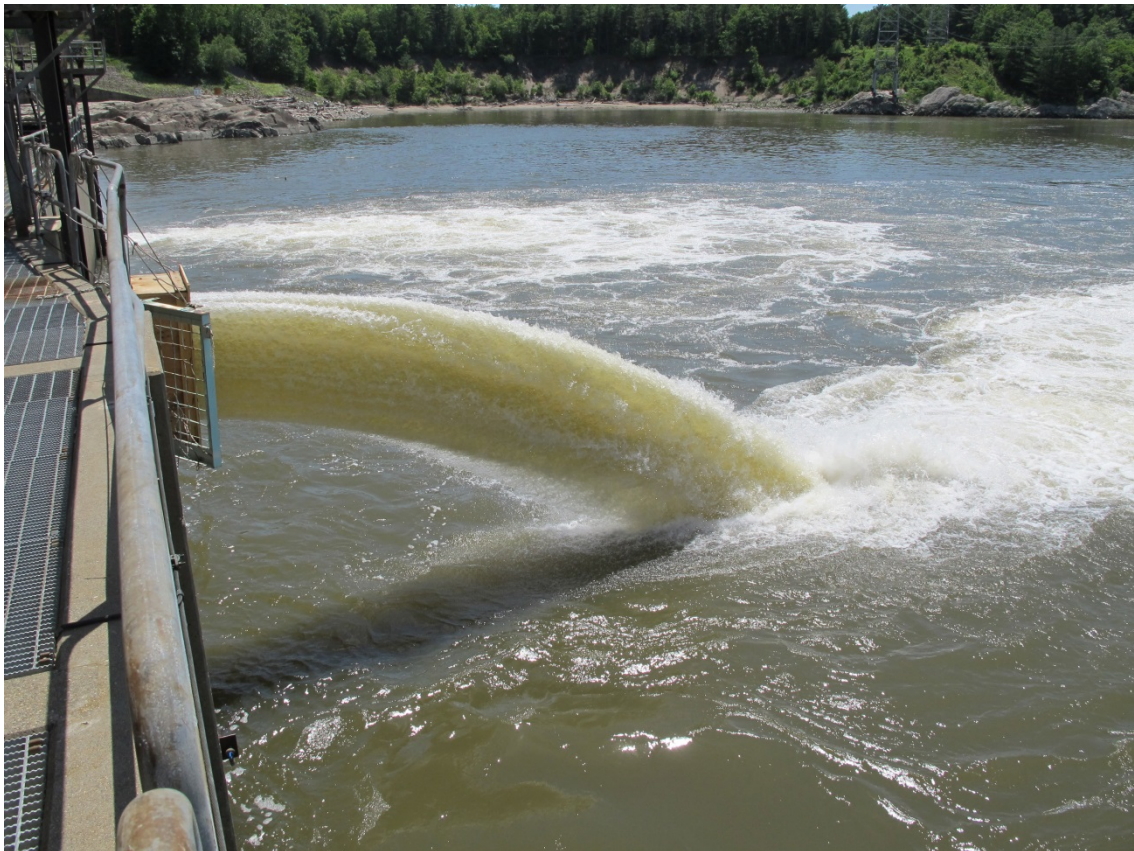
Abbildung 2.14 Bypass-Auslauf am Vernon Dam, Connecticut River, USA (Foto: C. R. Kriewitz)
