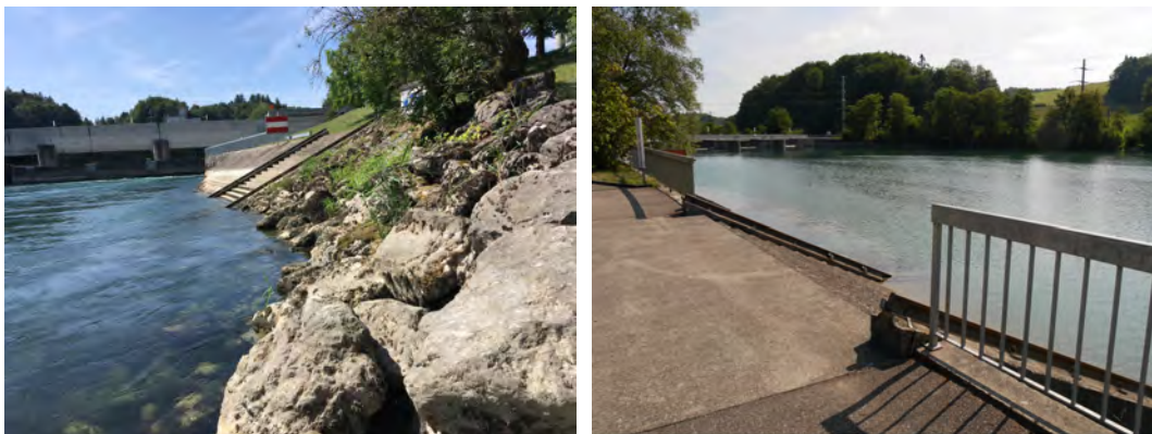
Abbildung 28: Rampe zum Ein-/Auswassern der Boote im UW (links) sowie im OW (rechts) des WKW BAN.
