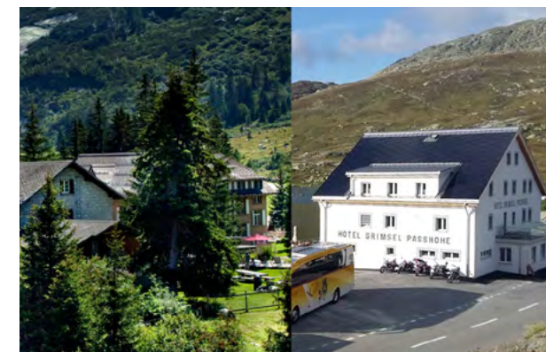
Fotos: Kraftwerke Oberhasli AG/David Birri, Patrizio di Renzo, hotel-grimselpass.ch
