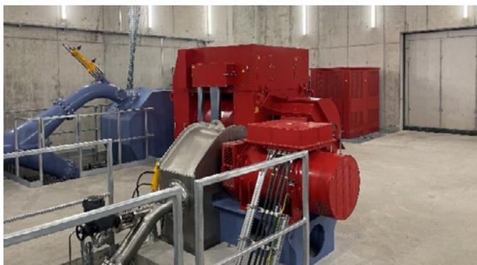
Neues Kraftwerk mit einer zwei-düsigen, horizontal-achsigen Maschine. Im Vordergrund die Trinkwasserturbine. Bilder: LWK.
