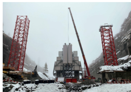
Baustelle Staumauer Spitallamm (Bild: SWV).
